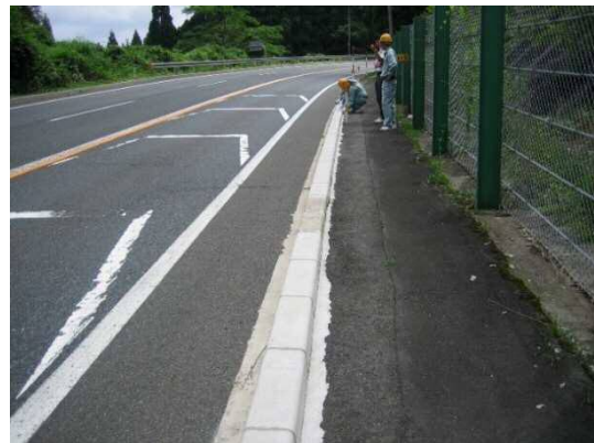
写真-5 凍害環境での使用例（歩車道境界ブロック）
