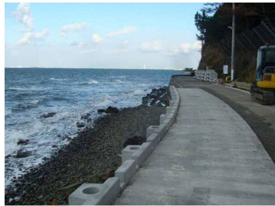
写真-3 塩害環境での使用例（張り出し車道）
